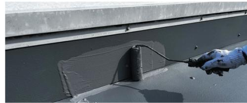
浸水対策の基本は、前段でも触れたクラックの確認です。幅が0.3mmを超えるクラックは建物内部への浸水が始まっている恐れがあり、早めの補修が必要です。浸水が進むと、木部の膨張や腐食が起こり、躯体の強度が著しく低下するほか、RC造の場合には内部の鉄筋が錆びて膨張し、周囲のコンクリートが破壊される「爆裂」が起こります。コンクリート内部へ浸水時は、亀裂のそばに白い模様が現れる「エフロレッセンス(白華現象)」が見られるため、危険信号として押さえておきましょう。
